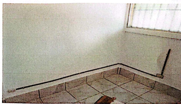
FOTO 4: Reparación de cableado eléctrico
