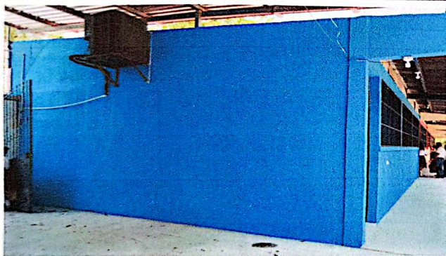
FOTO 3: Pintura en muros exteriores e interiores
