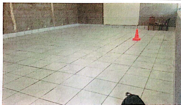
FOTO 2: Sustrucción de piso cerámico
